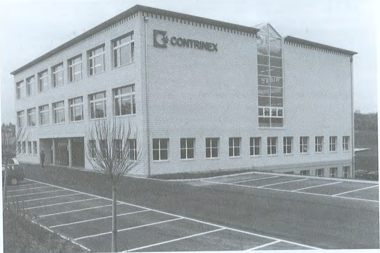
La nouvelle usine de Contrinex S.A. à Givisiez
